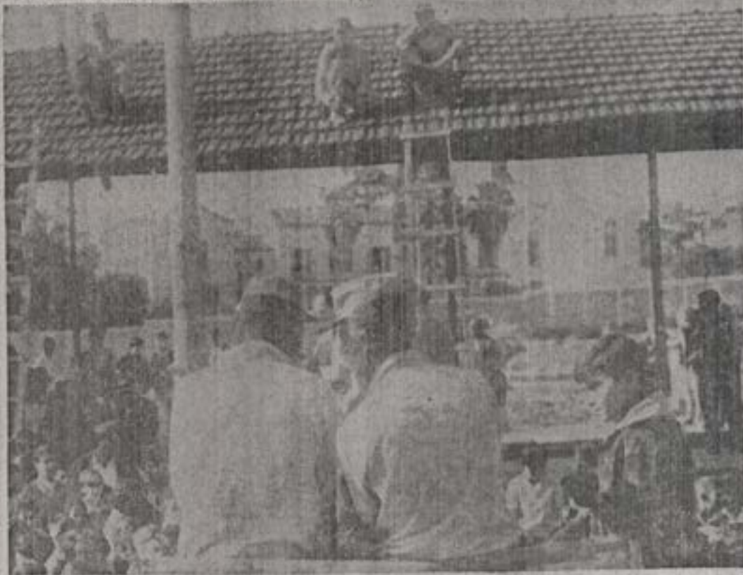
A demolição da pequena estação de Jaçanã começou ontem às 9 horas. Teve alegria, mas também teve gente chorando. A demolição dá um pouco de saudade.
