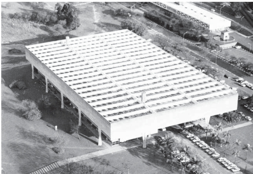
Imagem 3 - Faculdade de Arquitetura e Urbanismo da Universidade de São Paulo, Vilanova Artigas e Carlos Cascaldi, São Paulo/SP, 1961
